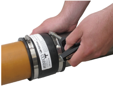
Fernco rörkopplingar: 6Nm
